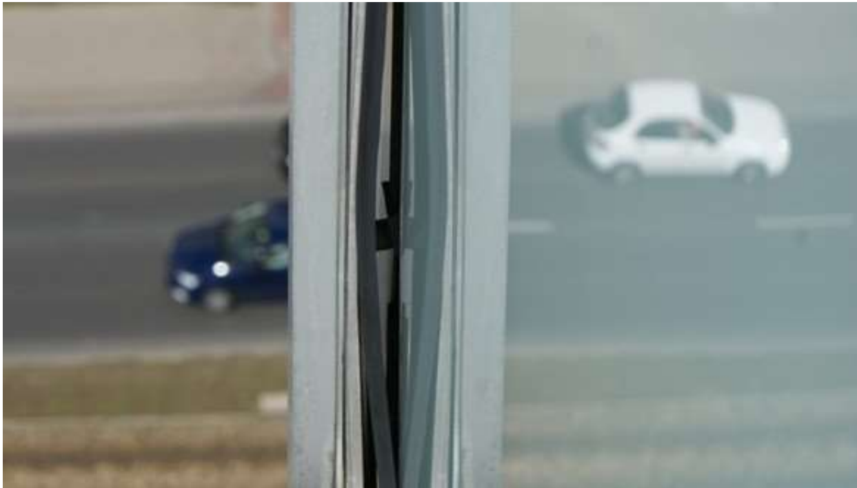
Wygięta listwa dociskowa oraz listwa maskująca, świadczy to o działaniu bardzo dużych sił na elementy elewacji
