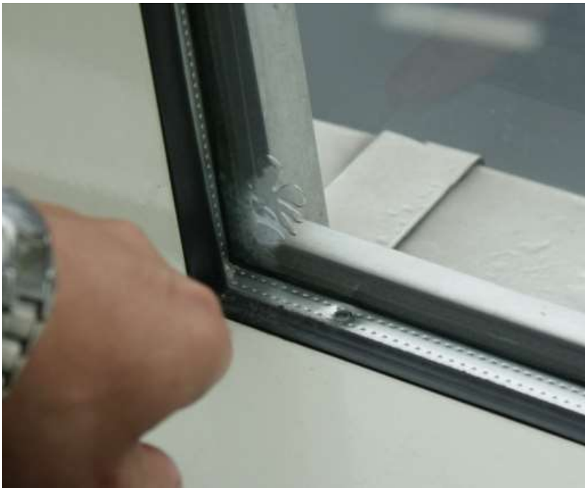
Przykłady wad laminowania płyty szklanej
