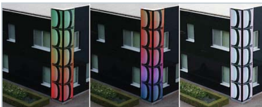
Fot. 2. TOTEM – Drooghmans, Balen 2009. Podwójnie szklone jednostki shadow box z diodami LED (system LEDinGLASS) tworzą świecący narożnik z logo firmy (fot. http://www.quantumglass.com )
