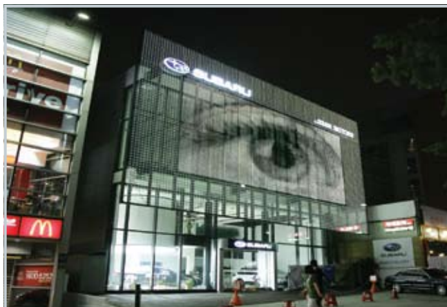
Fot. 5. SUBARU powerglass® media facade, Seoul 2010. Nocą szklana fasada stanowi świecący ekran reklamowy. Wyłączona w ciągu dnia jest wizualnie dyskretna, nie przeszkadza użytkownikom. Logo, napisy i animacje mogą być prezentowane z obu stron szklanej ściany (fot. POPSign, www.powerglass.com )
