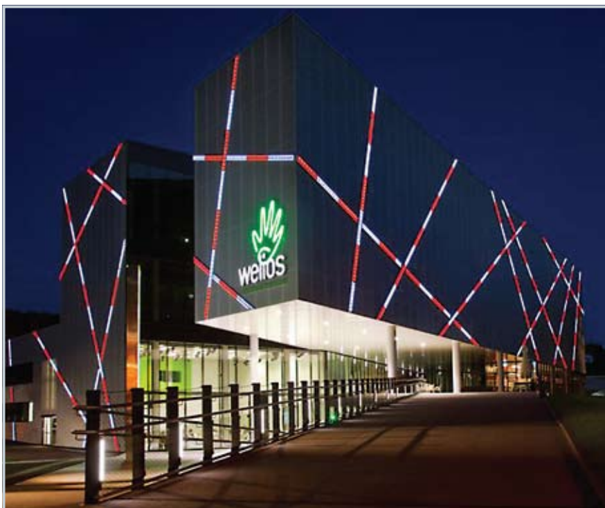
Fot. 14. Helios Science Center, Wels 2011. Na fasadach zamocowano łącznie 700 m świecących pasów LED/PV. Każda linia może być sterowana indywidualnie (fot. http://www.ledfassaden.at/ )
