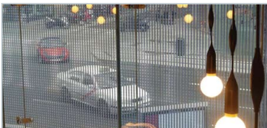
Fot. 8. Imaginarium, Madryt 2010. Paski diod LED zintegrowane ze szkłem laminowanym - widok z wnętrza sklepu. (fot. http://www.leuro.com )
