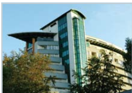
Apartamentowiec ETNA (ul. Portowa 18)
