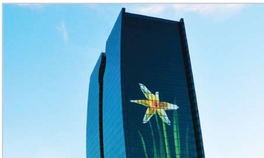
Fot. 9. King Road Tower, Jeddah. Szklany ekran LED pokrywa wysokość 21 pięter na fasadzie północnej i południowej oraz 16 na zachodniej (fot. CITILED, http://www.quantumglass.com )
